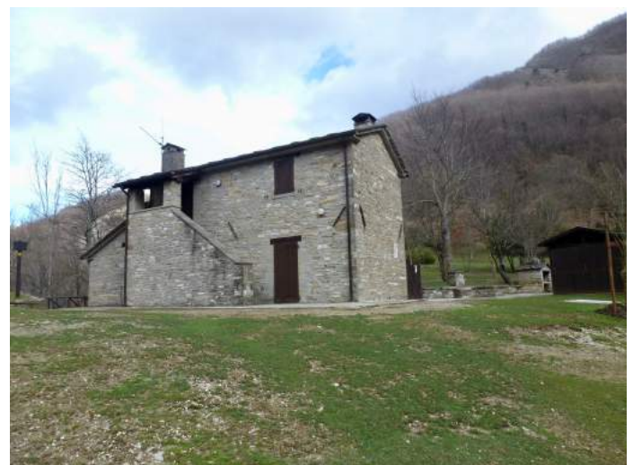
Foto n. 14 – Ca' di Sopra
