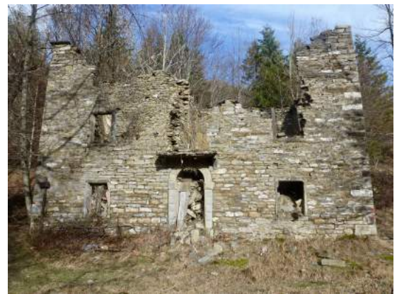
Foto n. 12 – il Casone oggi
